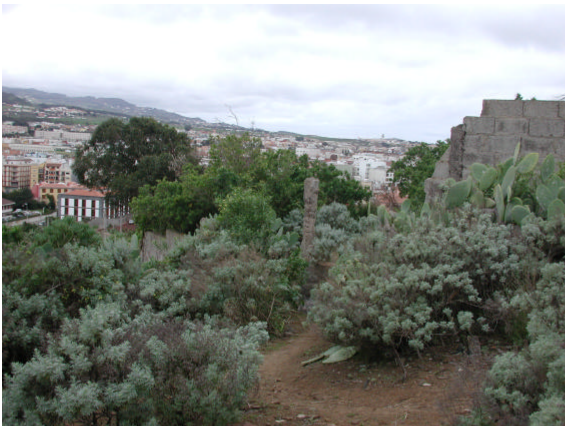
Figura 11. Muro de separación en la linde occidental
