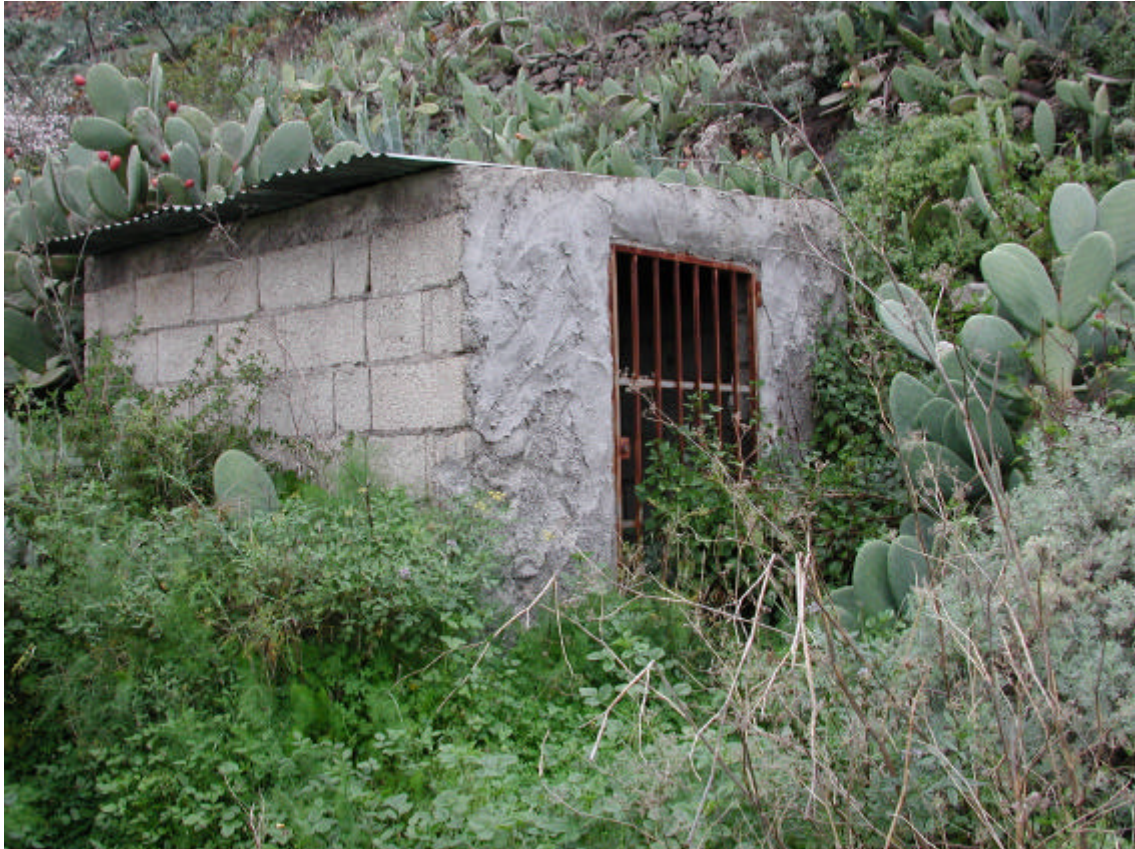
Figura 9. Detalle de la caseta de la bomba hidráulica
