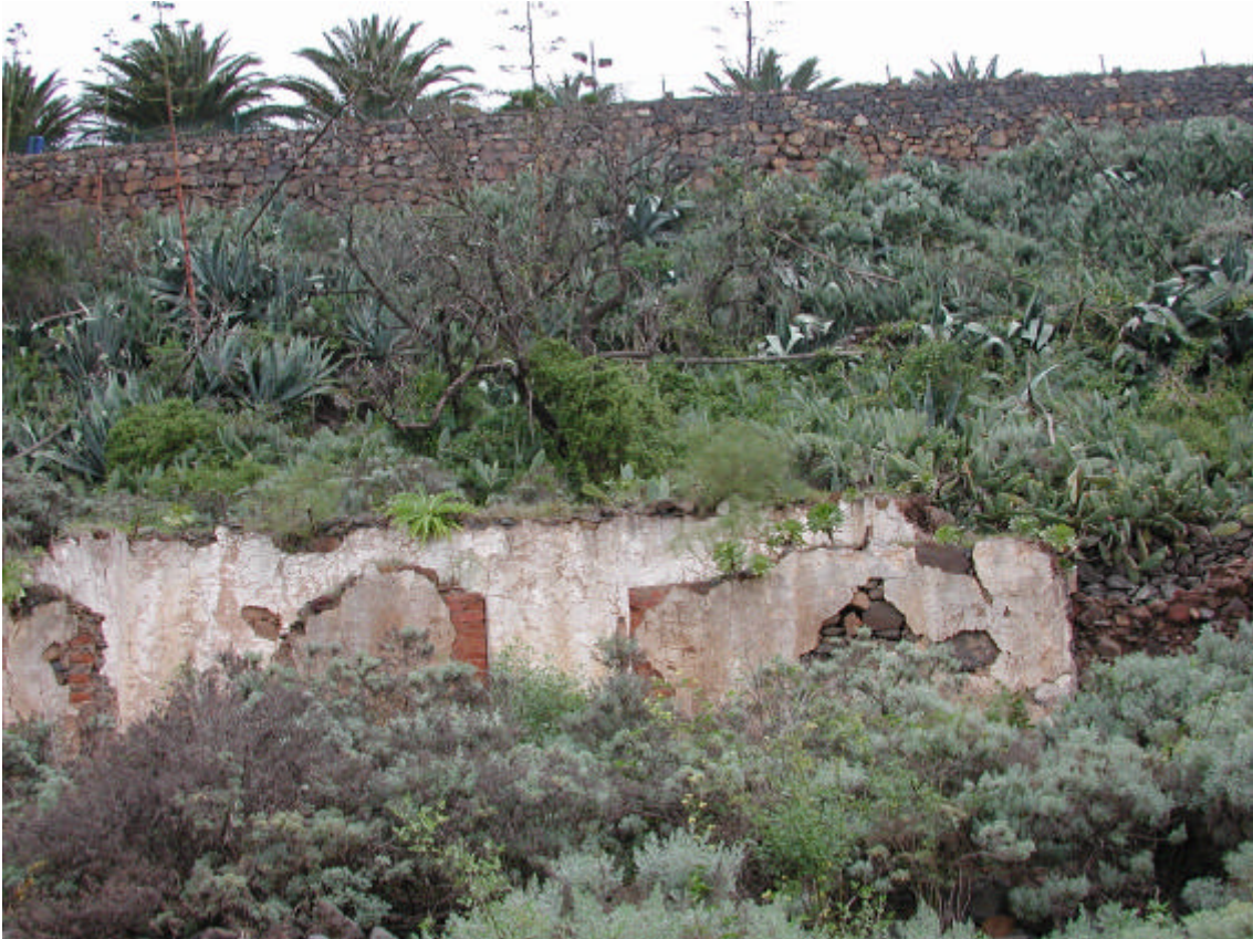
Figura 7. Edificio en ruina. Futura caseta de aperos y servicios higiénicos
