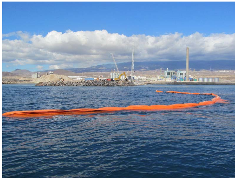
Figura 20. Barrera usada para mitigar la turbidez
