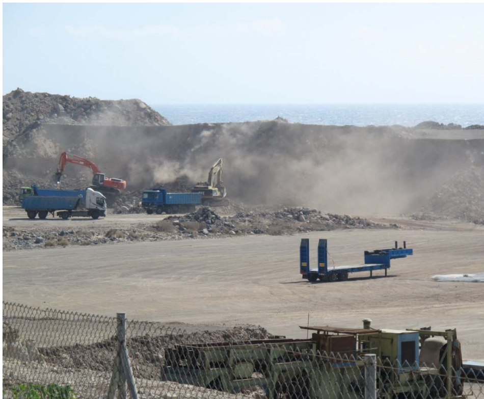
Figura 21. Polvo generado durante la carga de materiales (14 de octubre 2011)
