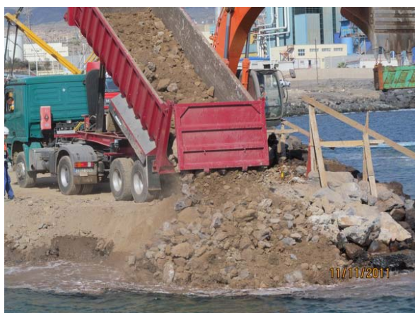
Vertidos en las obras del dique norte 11 de noviembre 2011
