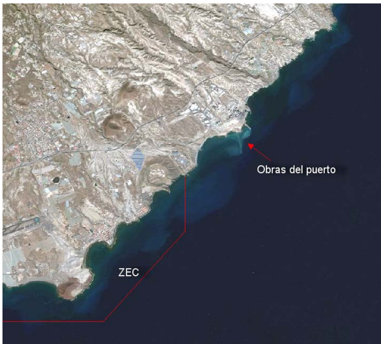
Figura 25. Imagen tomada por el satélite Worldview-2 el 1 de diciembre de 2011 en la que se aprecia la pluma de turbidez generada por las obras. La pluma cambia con las corrientes de marea y, en principio, debería mostrar un avance neto hacia el SW siguiendo la dirección de la corriente de Canarias imperante. No obstante, se aprecian flujos y reflujos que pueden estar vinculados a la irrupción de las obras de abrigo del puerto, y cuya evolución requiere tiempo de estudio.
