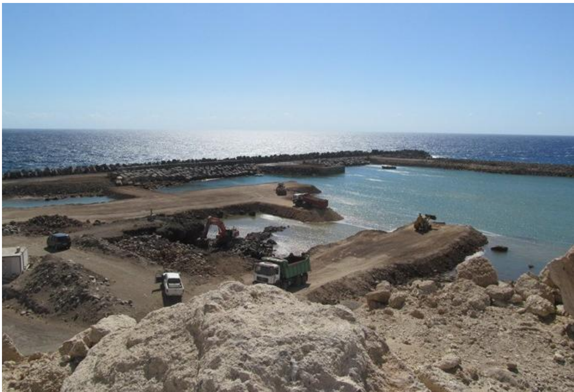
Figura 6. Rellenos en el dique tras el cierre de las ataguías, el 7 de agosto de 2012.
