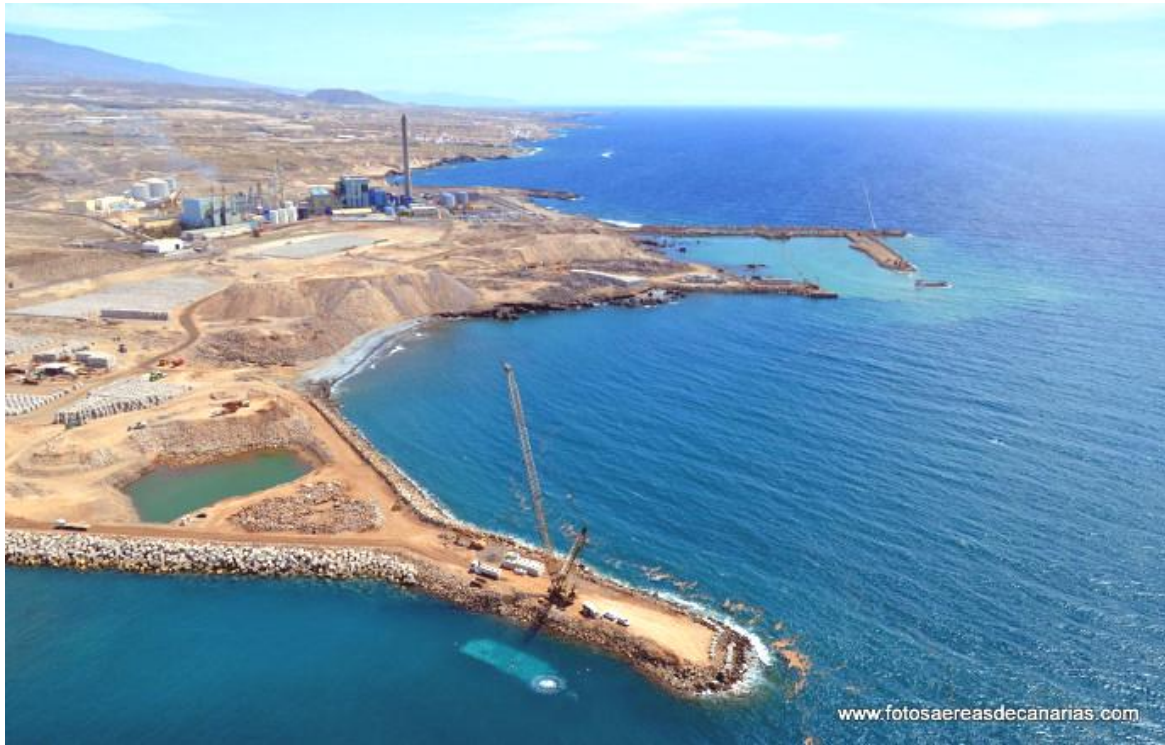
Figura 5. Situación general de las obras el 9 de mayo de 2012.
