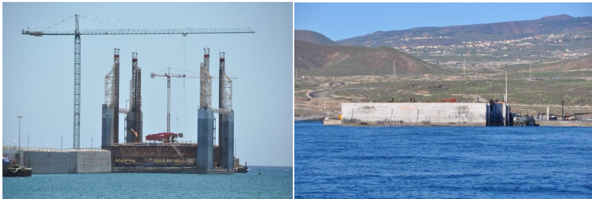
Figura 7. Fabricación de cajones en el puerto de Santa Cruz y el quinto cajón colocado en el contradique de Granadilla el 20 de noviembre 2012.
