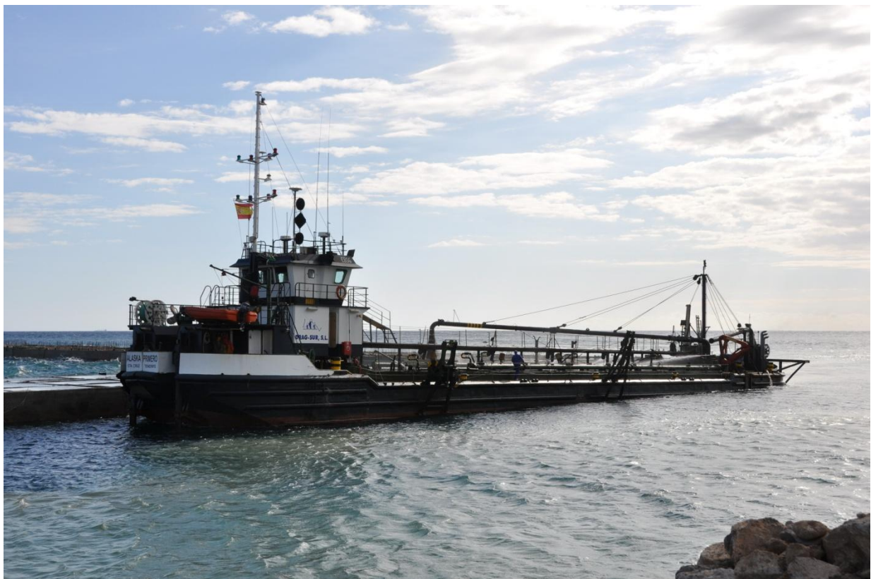
Figura 17. Draga rellenando uno de los cajones del contradique (12/12/2012)
