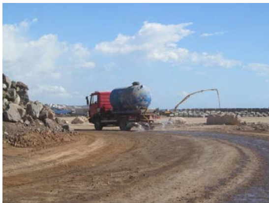
Figura 18. Riego de los viarios con cuba y del material durante la carga
