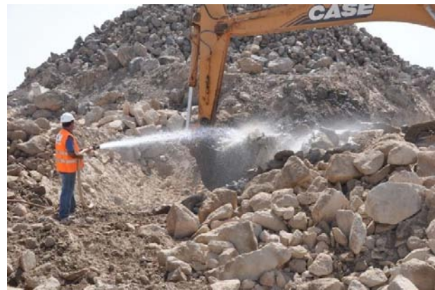
Figura 18. Riego de los viarios con cuba y del material durante la carga
