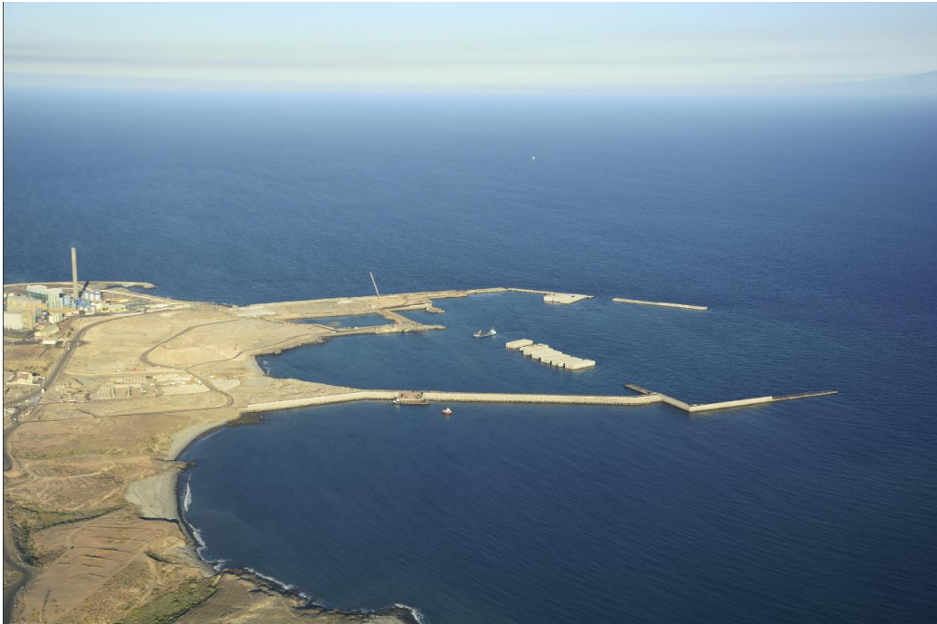
Figura 6. Panorámica general de la situación de las obras de construcción del nuevo puerto industrial de Granadilla (Foto Canary, 21 Enero 2016)
