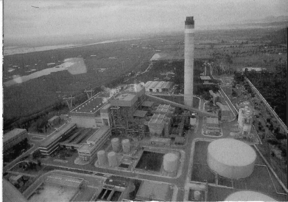
Es Murterar. Central elèctrica de carbó, que subministra corrent a Mallorca i Menorca.
